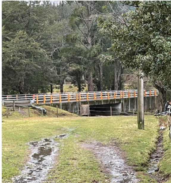
Actual foto del Puente Trafampulli, con diseño para que ruta S 965 cruzara el Rio Trafampulli, hoy seco por la construcción del dique o muro. Jorge Saez Bustos. Rut 21.928.616-3
